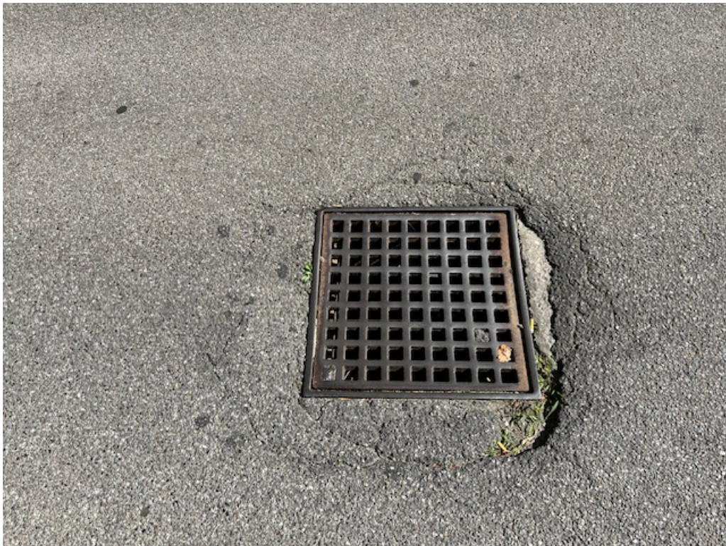
Foto n.12- Particolare caditoia Via Cavour
